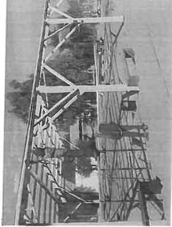
SUMINISTRO, HABILITADO, MONTAJE, NIVELACION Y PLOMEO DE PTR DE 4"X4" X 3/16" EN CONTRAVENTE, PARTEAGUAS, Y LARGUERO DE ENTRE EJE. INCLUYE SOLDADURA, LIMPIEZA DE CORDONES, PINTURA ANTICORROSIVA Y ESMALTE.
